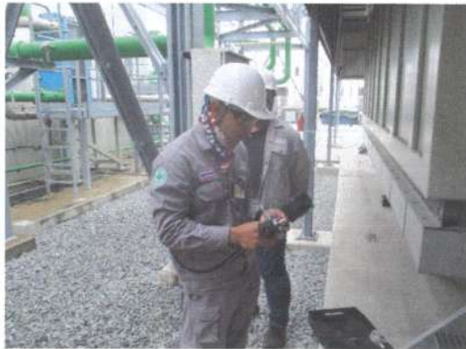
รูปการทดสอบเปรียบเทียบมาตรฐานวัดความดัน
